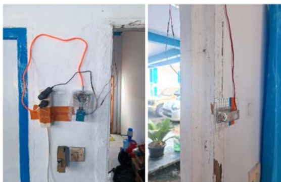
Gambar 12. Implementasi Perangkat Prototipe Pada Bagian Depan dan Belakang Kamar
